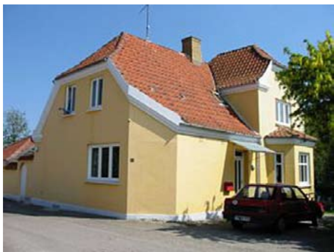
Birkevej 13 butiksvindue og døren muret til
